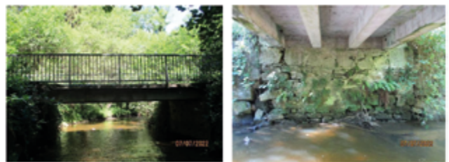
Exemple d'un pont étudié à Vicq-sur-Breuilh
